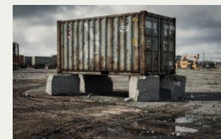
Kontener na luźnych bloczkach
